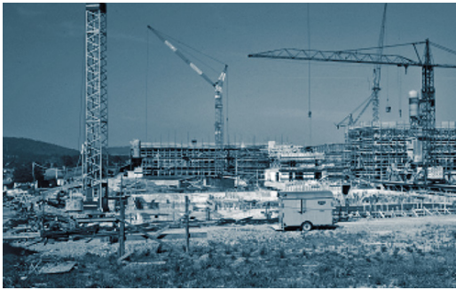
Costruzione degli edifici a Reckenholz, Zurigo-Affoltern nel 1967
