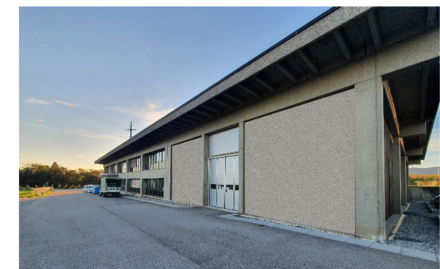
Figure 6: Exemple de rénovation avec crépit peint sur façade de la cave
