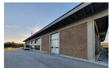
Figure 5: Exemple de rénovation avec bardage bois sur façade de la cave
