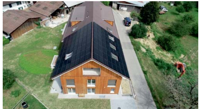
Installation photovoltaïque à Künten AG
