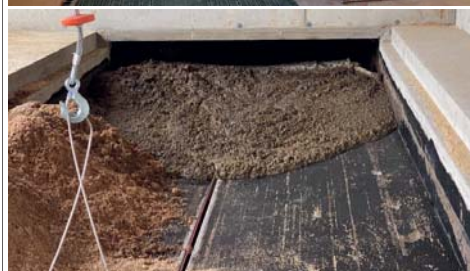
Racleur souterrain et rigole d'évacuation d'urine
