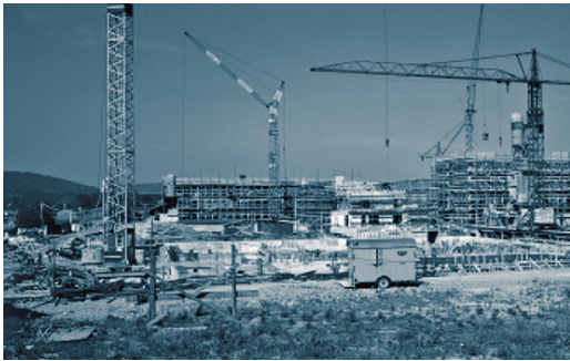
Bau der Gebäude im Reckenholz in Zürich-Affoltern 1967
