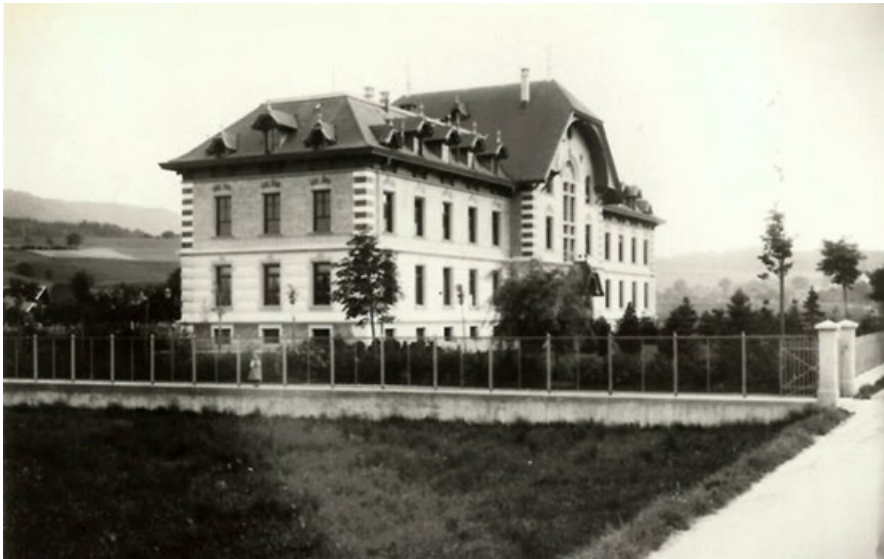
Schweiz. landw. Versuchs- und Untersuchungsanstalt Bern (Liebefeld) – Hauptgebäude
