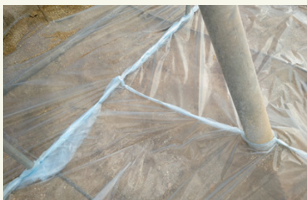
Fig. 4: La sigillatura di strati di film può essere effettuata a mezzo pinzatura.
