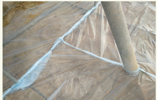
Fig. 4: Les couches de film peuvent être scellées par agrafage.
