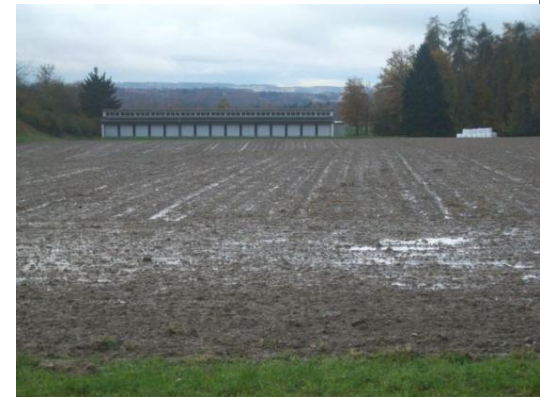
Tassement visible en surface
