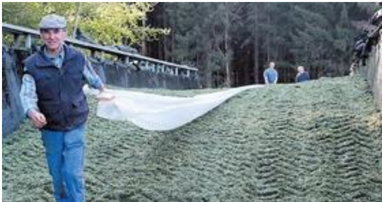
Zuerst Unterziehfolie (luftdicht)
