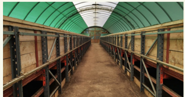
Abb. 2: Eingehauste, kontinuierliche Wurmkompostanlage, Österreich.
