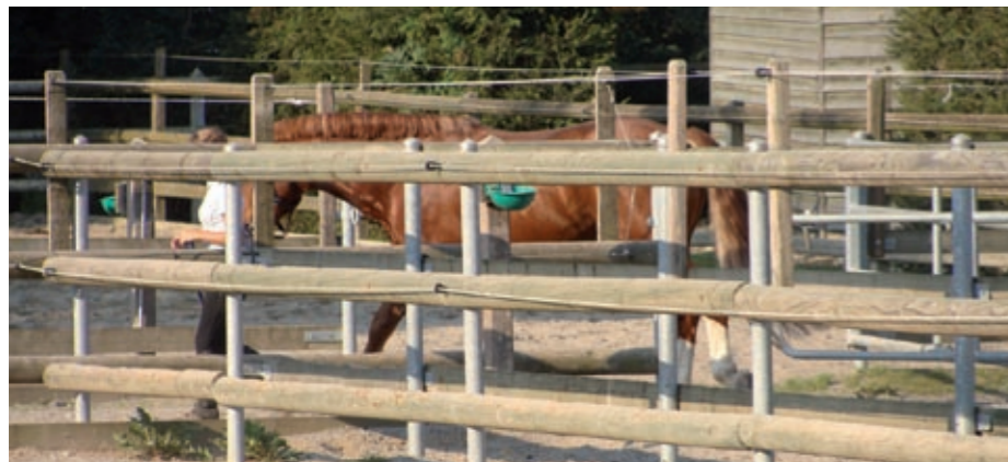
Holzfrassschutz durch Kombination Holz mit Elektrozaun
