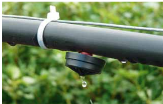
Figure 2 | Goutteur en dérivation. Pour fixer le tube d'alimentation, un fil supplémentaire est tendu sur l'armature de soutien de la culture à 40–50 cm du sol.
