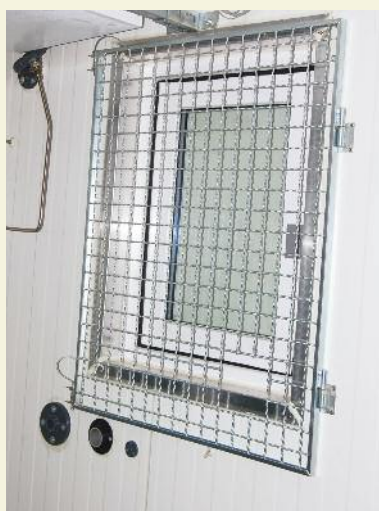
Abb. 3: Sicherheitsgitter am Fenster eines CA-Lagerraums.
