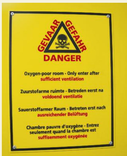
Abb. 2: Warnhinweis auf der Tür eines CA-Lagerraums.
