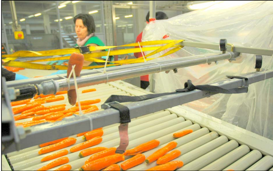
Abbildung 19: Provisorische Hochdruckanlage über dem Sortierband
