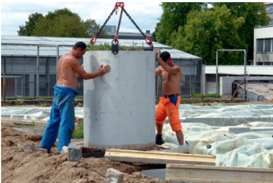
Une grue met en place une carotte de trois tonnes dans l'installation de mesure des eaux d'infiltration.
