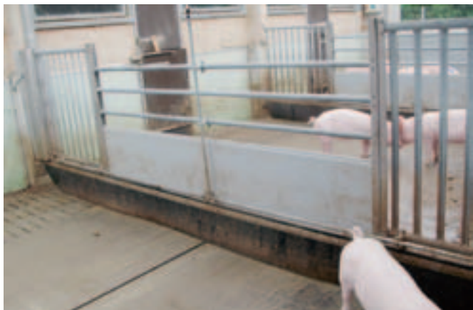
Abb. 11: Doppelter Gummilatz unter der Buchtenabtrennung als Schutz gegen das Durchschlüpfen von Schweinen.
