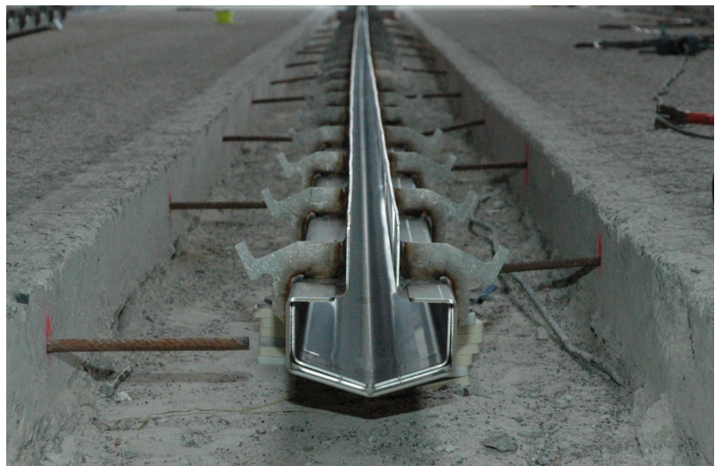
Abbildung 5: Nachträglicher Einbau einer Harnsammelrinne in bestehendem Stall (Bild: Agroscope)
