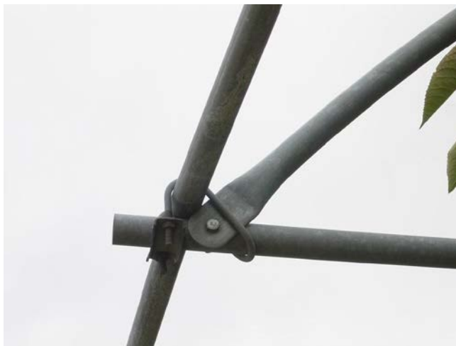
Photo 3: CCD, le montage de ce système est effectué principalement avec des brides de fixation vissées, ce qui le rend très flexible.
