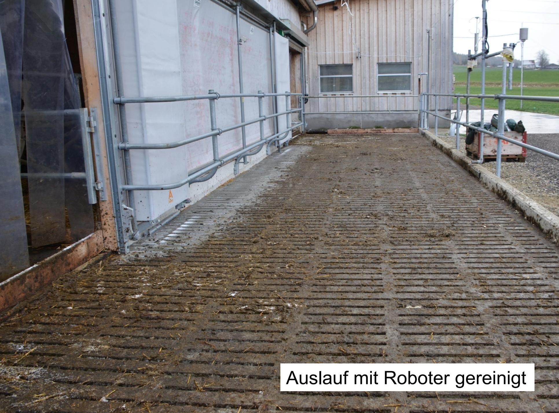
Auslauf mit Roboter gereinigt
