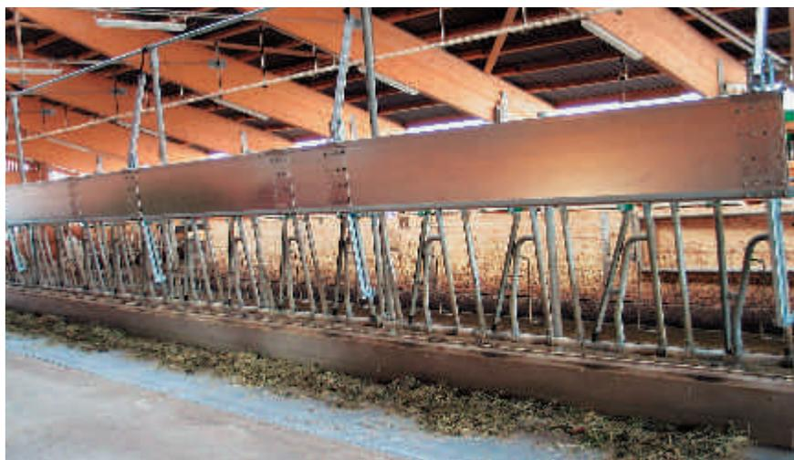
Fig. 2: Pour faciliter le nettoyage de l'aire d'affouragement, le bord de crèche est relevé.
