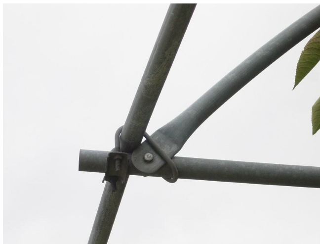
Abb. 3: CCD, die Montage dieses Systems wird vorwiegend mit verschraubten Spezialrohrbriden gemacht. Es ist daher sehr flexibel.
