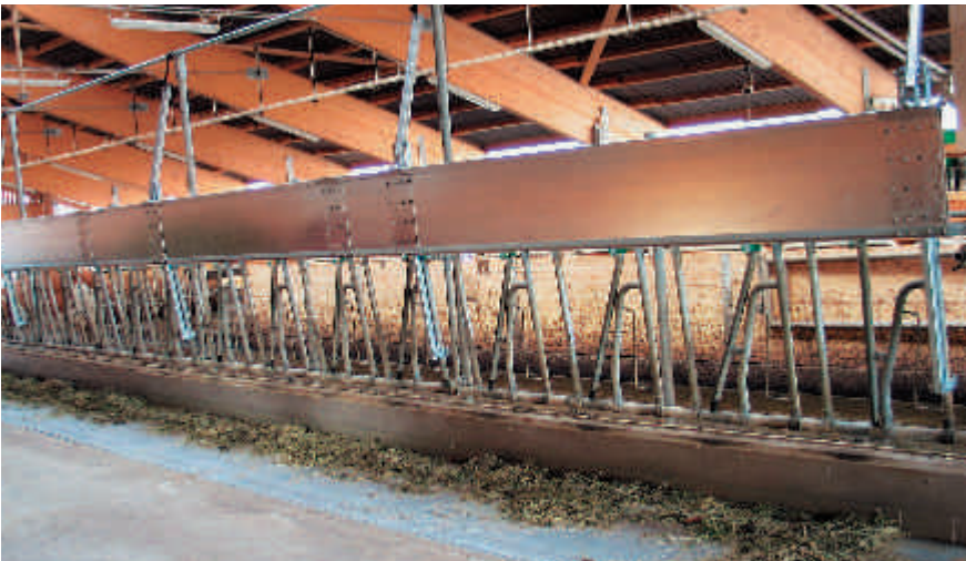
Abb. 2: Zur ungehinderten Reinigung des Fressbereichs wird der Krippenrand hochgezogen.
