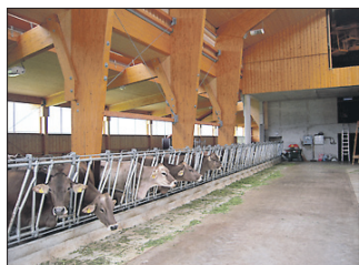
Unterstützung beim Stallbau
