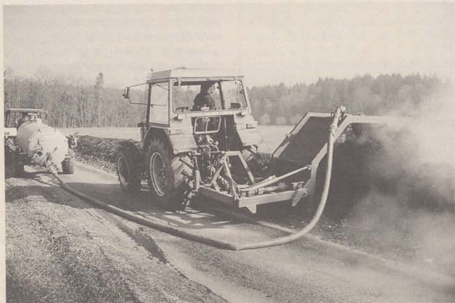
Fig. 11. Humidification de l'andain pendant le brassage. Il est préférable de mélanger l'eau à l'andain que d'arroser en surface.
