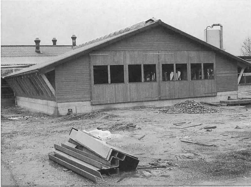
Abb. 5. Beim Versuchsstall handelte es sich um einen einfachen, schwach isolierten Baukörper mit Trauf-First-Lüftung mit aussenliegenden Bedienungsgängen. Das Unterdach bestand aus lediglich 2 cm Noppenfolie ( $k$ -Wert:  $1,0 \text{ W/m}^2, \text{ }^\circ\text{K}$ ).
