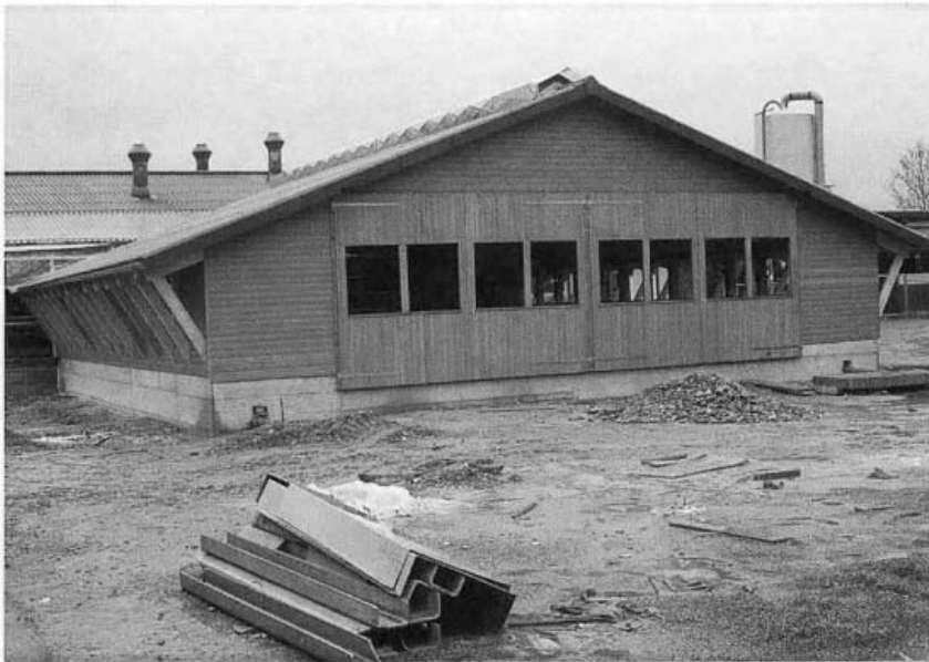
Fig. 5: La porcherie d'essai consistait en un corps de bâtiment simple, peu isolé, avec une ventilation statique par le faite. Les couloirs de service étaient extérieurs. La sous-toiture consistait simplement en une feuille alvéolaire de 2 cm (valeur k : 1,0 \text{ W} / \text{m}^2, \text{ }^\circ\text{K} ).
