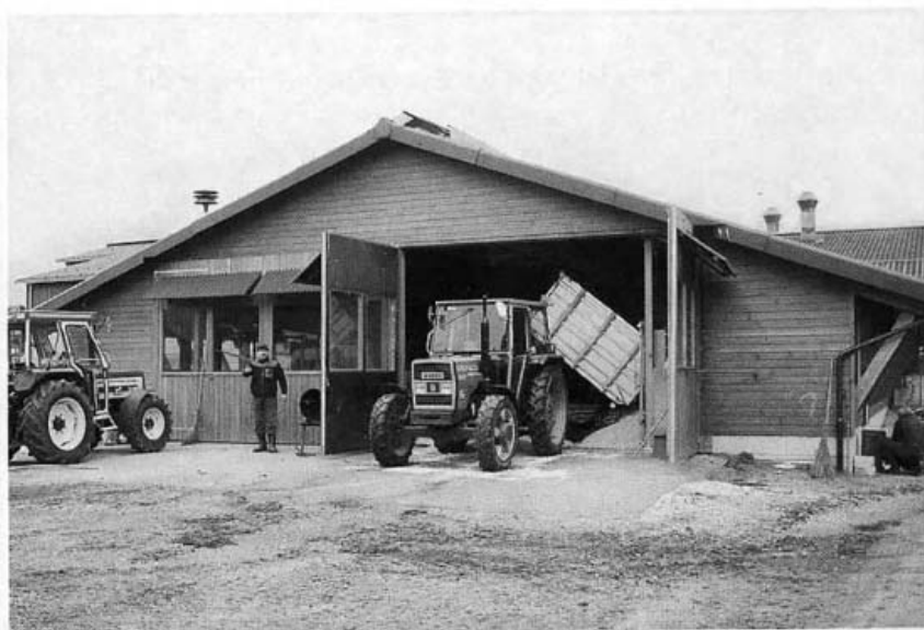
Fig. 7: De larges portes du côté du pignon facilitent l'entrée avec le tracteur et les engins de travail de la litière, ainsi que l'apport de la sciure et l'enlèvement du compost.
