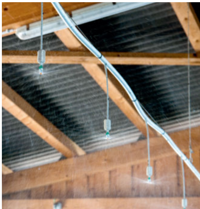
Mit grosstropfigen Düsen lassen sich die Laufflächen in kurzer Zeit befeuchten. Bild: Michael Zähler
