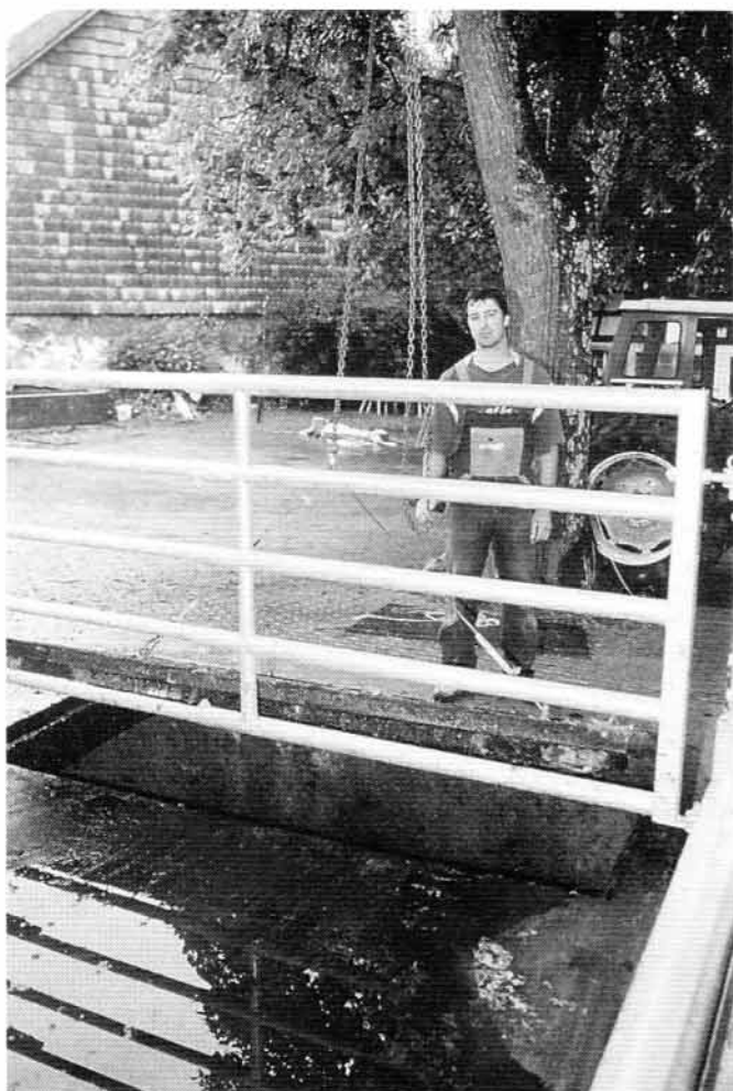
Fig. 19. Placer l'évacuation en dehors de la zone clôturée présente un avantage: les animaux ne courent aucun danger durant les travaux de nettoyage (Photo SPAA).
