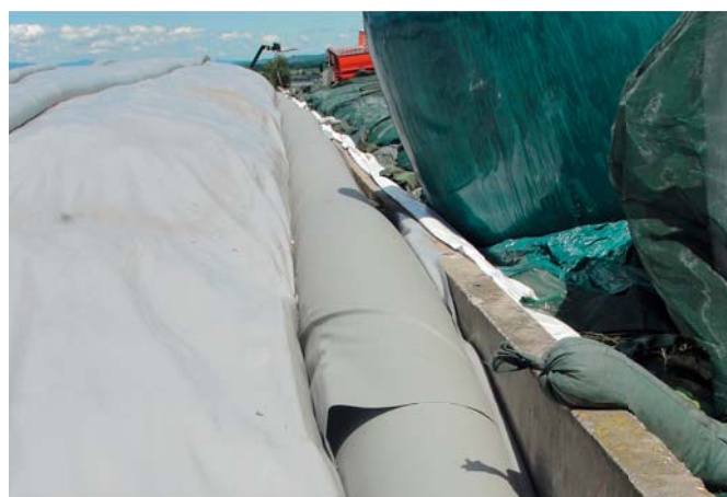
Fig. 15: Un tubo di grande diametro, riempito d'acqua e posato lungo la parete del silo, rende il silo perfettamente ermetico, impedendo l'entrata dell'aria.
