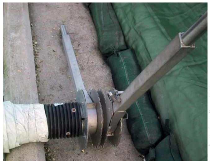
Fig. 13: Martinetto meccanico per svolgere e tendere efficacemente il film protettivo esterno.
