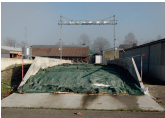
Ce silo-couloir de 6 m de large et de 26,5 m de long a servi aux essais. En haut sur la photo, on distingue le pont de mesure à ultrasons qui a servi à déterminer le volume du silo.
