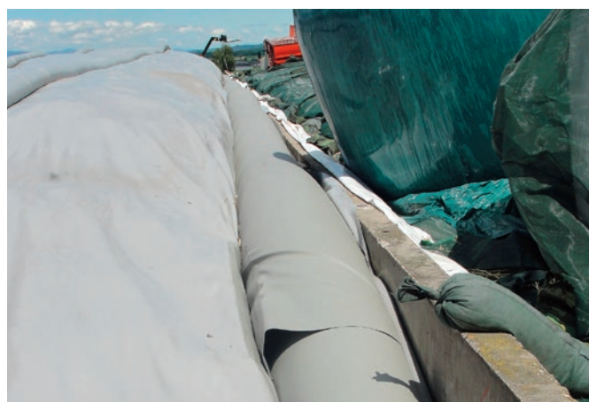
Fig. 15: Tuyau à eau extralarge le long de la paroi du silo pour une fermeture parfaitement hermétique à l'air.
