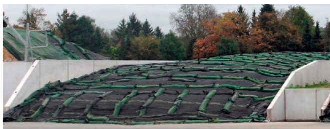
Fig. 11: Lorsqu'on pose la bâche, les sacs de lestage devraient être placés à intervalles serrés pour assurer qu'il n'y ait pas de poche d'air à l'arrière.
