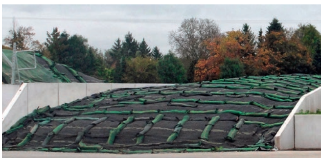
Abb. 11: Bei der Verlegung der Querriegel sollten die Abstände für einen guten Luftabschluss nach hinten in kurzen Abständen erfolgen.
