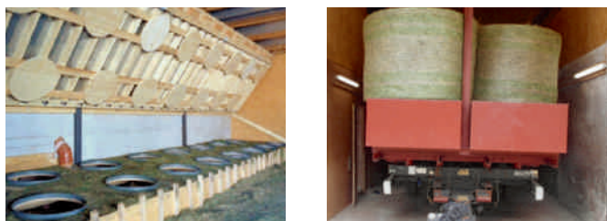
Abb. 13: Links zweireihige Anlage mit Holzkanal und schwenkbarer Deckelebene kombiniert als Hackguttrocknung; rechts Wagentrocknung.
