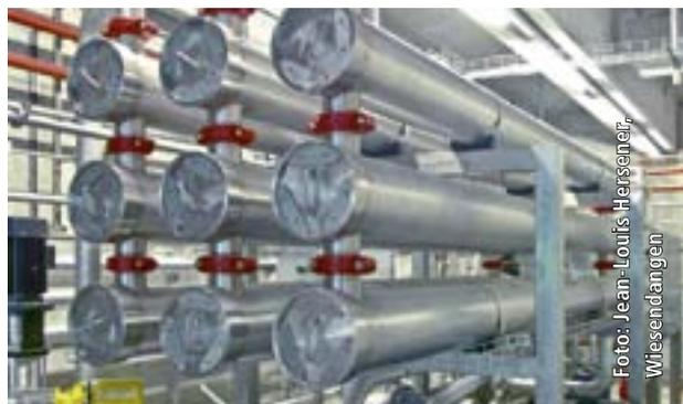
Abb. 3 | Umkehrosmose-Anlage.
