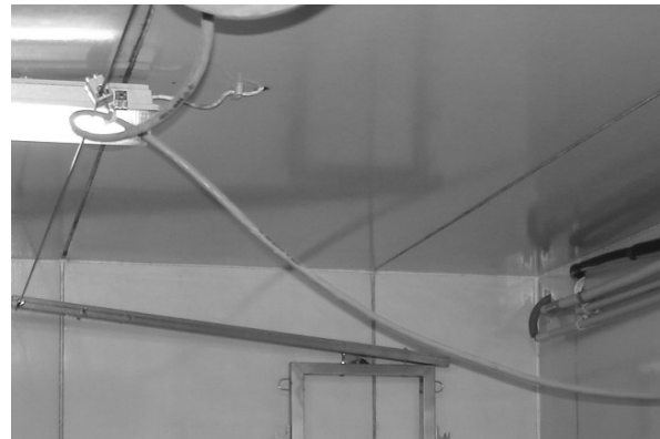
Abb. 10: Gutes Beispiel einer Aufhängung ohne Deckebohrung
